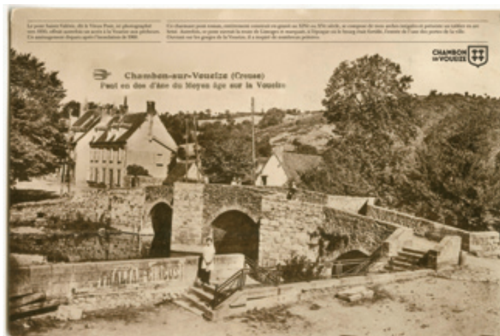
Pont en dos d'âne du Moyen-âge sur la Voueize
