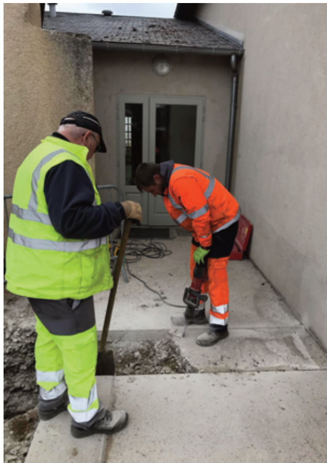
Travaux devant la salle des fêtes
