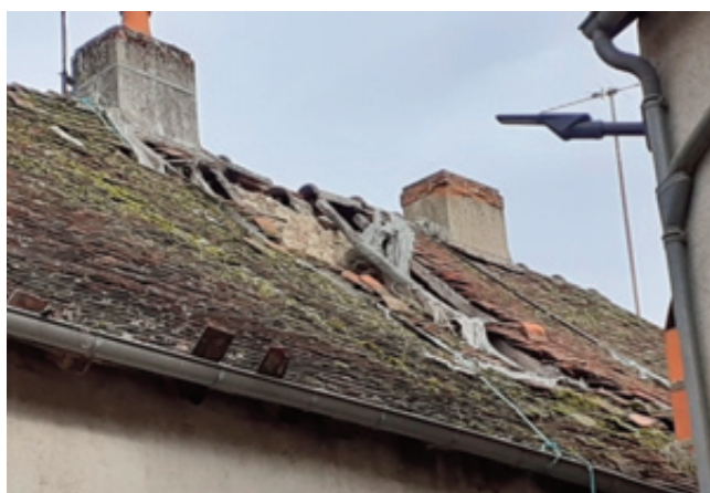
Toiture maison Tilbury
